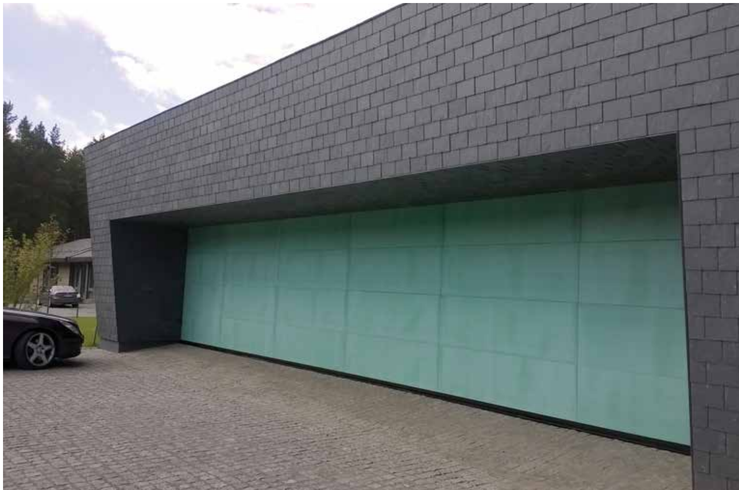
11 metrų pločio vartai apklijuoti žalio vario skardos lakštais.
