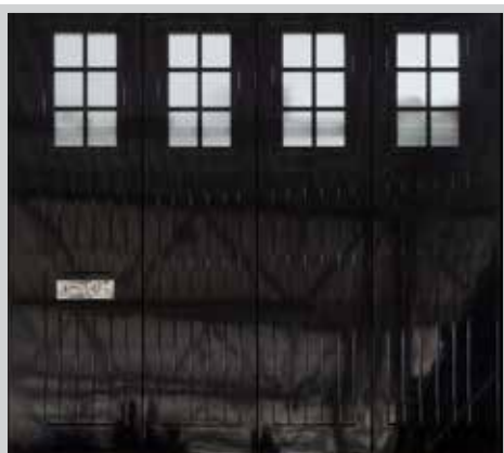
Į šoną nustumiami vartai su nestandartiniais langais, integruota pašto dėžė ir 80% blizgumo dažymu.
