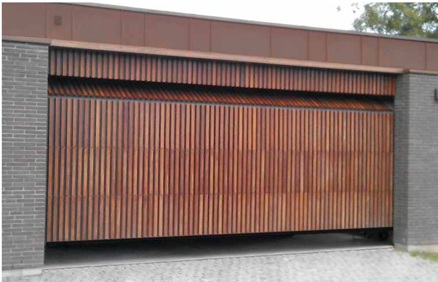
Garažo vartai ir dirbtinė sąrama apklijuoti 50x50mm maumedžio lentelėmis.
